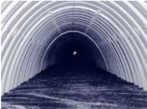
Spülbare Kammerreihe mit gewebtem Geotextil als Sohle
