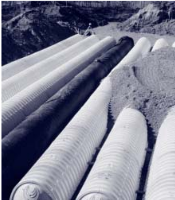
Einbau einer spülbaren Kammerreihe SC 740
